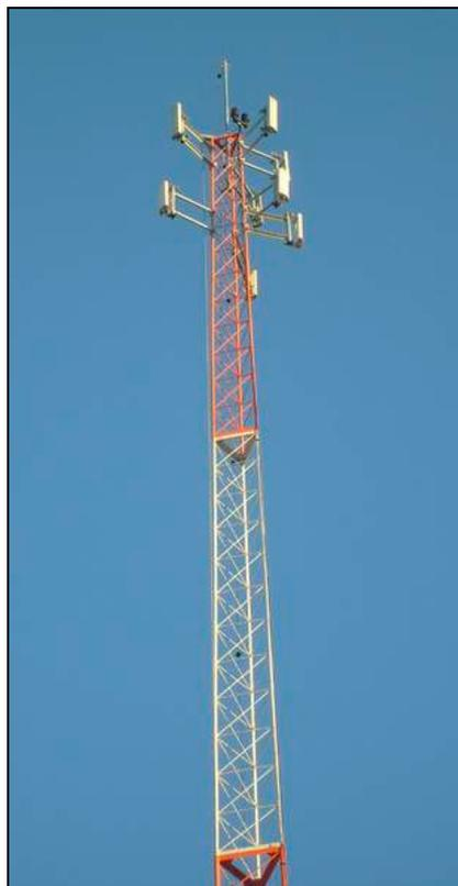
Figura 32 – Exemplo de uma Torre Estaiada de 30 metros para colocação das 4 Antenas.
