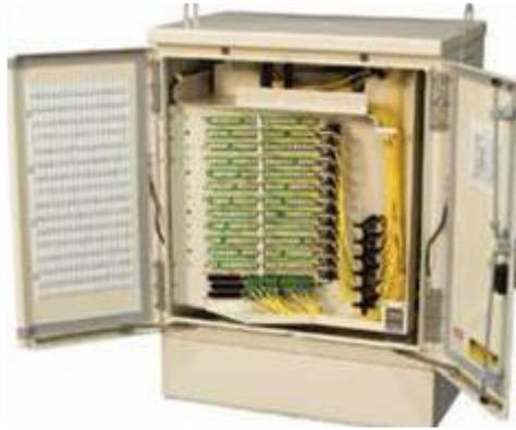
Figura 23: modelo de ONU ADC.
