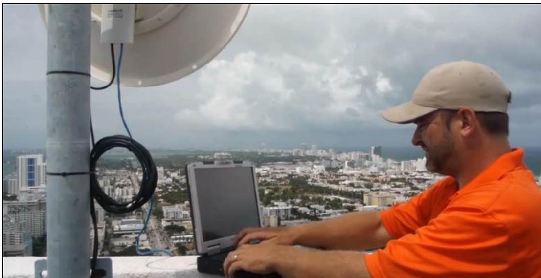
Figura 35 – Uma antena sendo instalada e configurada com o *software* do fabricante.
